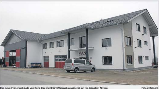
Das neue Firmengebäude von Kanz Bau steht für Effizienzbauweise 55 auf modernstem Niveau. Fotos: Reichel
